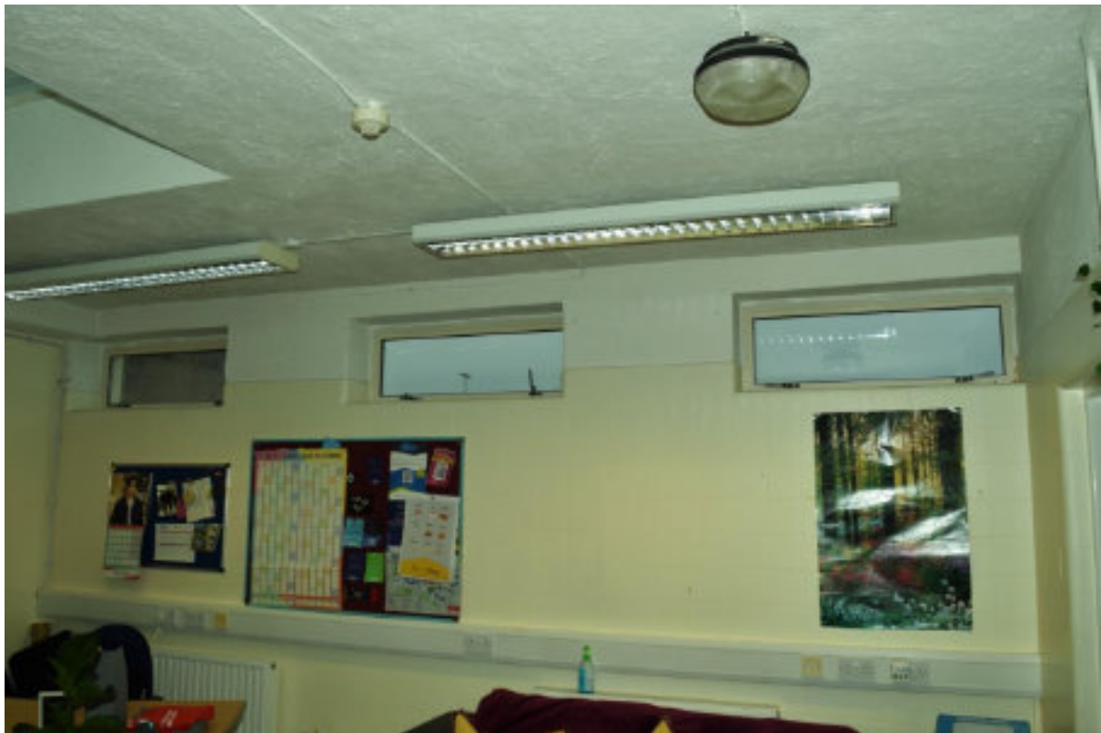
Figure 234 SU R24 NE elevation from SE.
