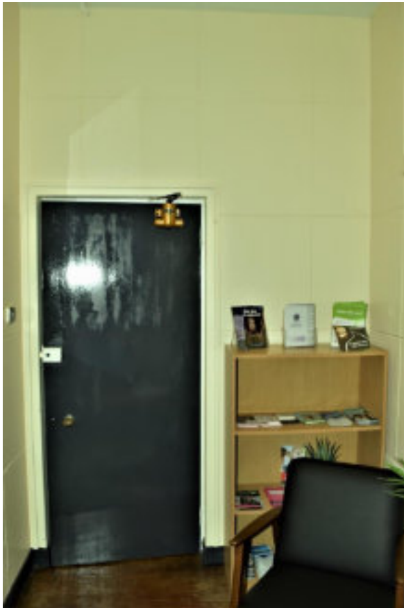
Figure 210 SU R9 NE elevation.
