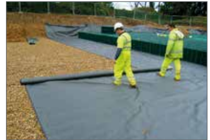
Step 3 - Lay geotextile / membrane.
