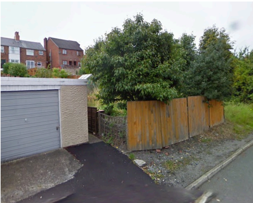
Rear of 9A Stanley Road, Ponciau
