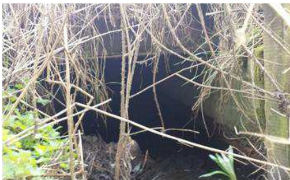
Culvert 3 Inlet (0340_C) Culvert Inlet + Circular Conduit
