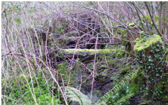
Culvert 2 Inlet (0467C) – inaccessible Culvert Inlet + Circular Conduit
