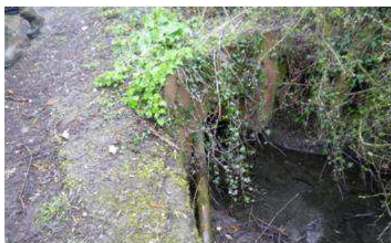
Culvert 1 Outlet (0862C) Circular Conduit + Culvert Outlet
