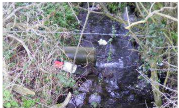
Culvert 3 Outlet (0238_C) Circular Conduit + Culvert Outlet
