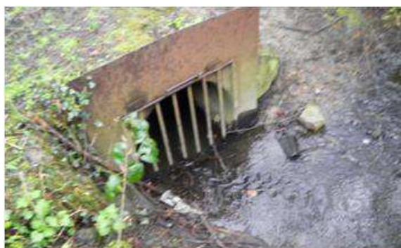
Culvert 1 Inlet (0870C) Culvert Inlet + Circular Conduit
