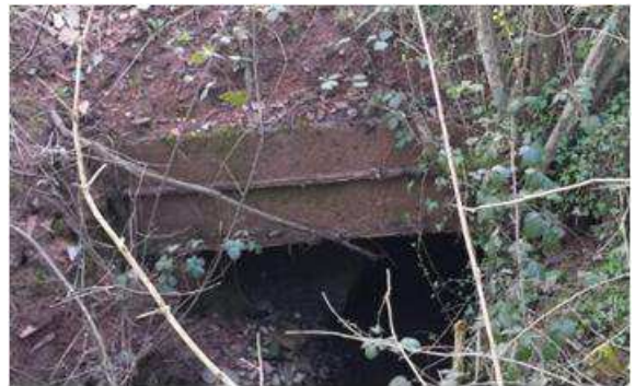
Culvert 2 Outlet (0436C) Circular Conduit + Culvert Outlet
